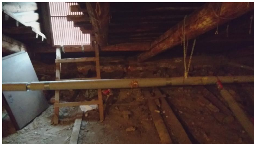
Рис. 25.19 Жалюзи на двери чердачного выхода.
